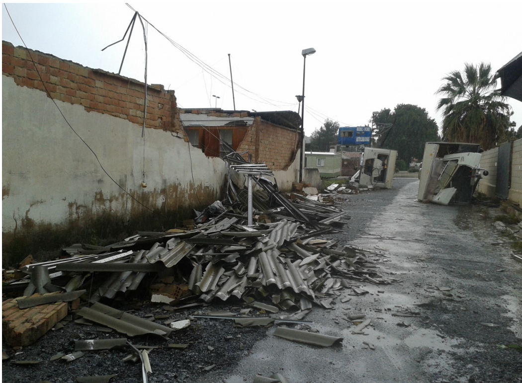
Figura 4.2. Pared y tejado derribados, y vuelco de dos caravanas
