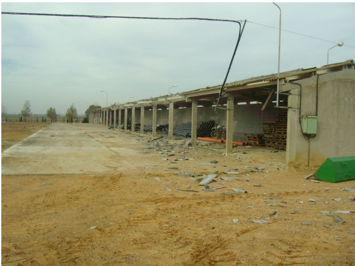
Figura 14. Cobertizos y tendido eléctrico afectados en la Dehesa La Atalaya (Coria del Río). Fuente de la foto: AEMET
