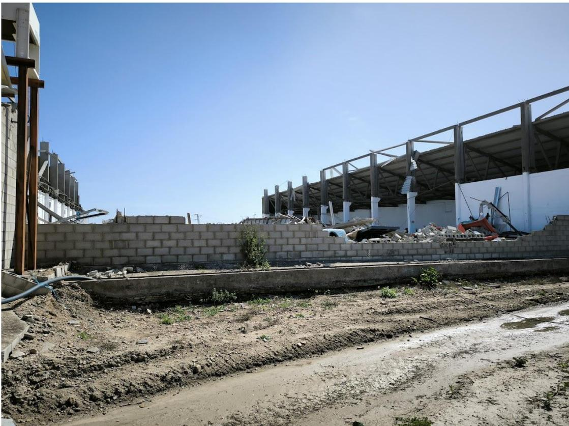
Figura 10. Imagen de la nave siniestrada tomada desde la fachada sur, se aprecian los restos del muro trasero, el tejado de la nave central completamente destruido, mientras que los pilares que soportaban toda la estructura así como el tejado de una de las naves laterales se aprecian indemnes.
