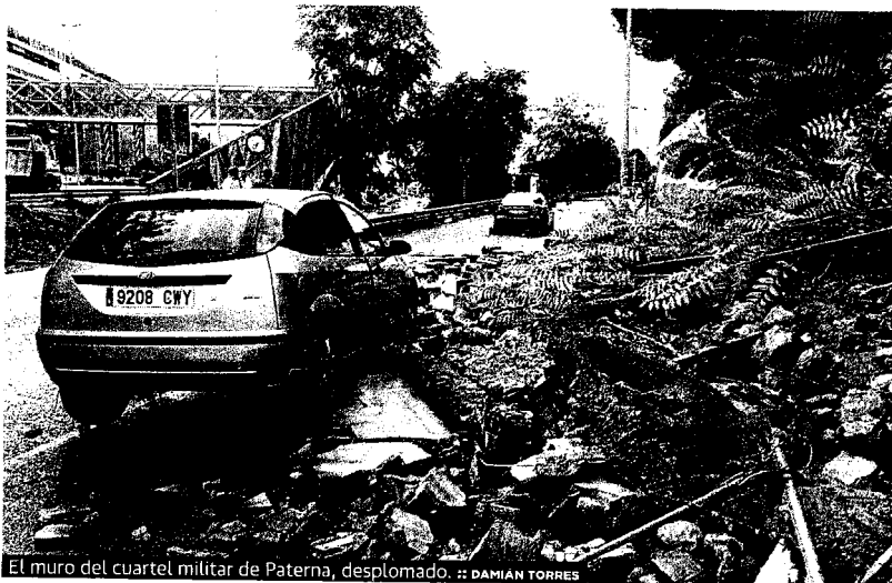
El muro del cuartel militar de Paterna, desplomado. :: DAMIÁN TORRES
