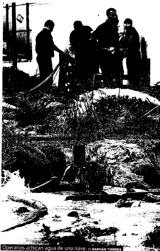
Operarios achicando agua de una nave. :: DAMIÁN TORRES
